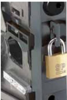
„Vysunutá“ poloha blokována visiacími zámkami.
