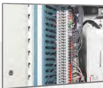
► CAB 3™, rovnaké označenie vodičov, káblov alebo radových svoriek: univerzálny označovací systém CAB 3™ pre celý rozvádzač
